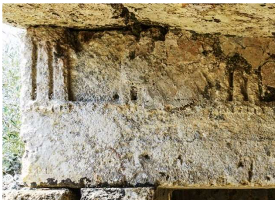
Blocco a fregio dorico riutilizzato come architrave (foto G. Negro)
