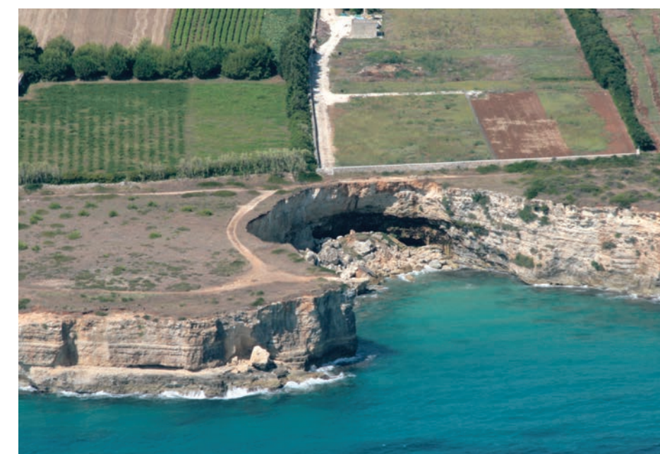
Otranto, falesia soggetta a fenomeni di crolli e cedimenti
