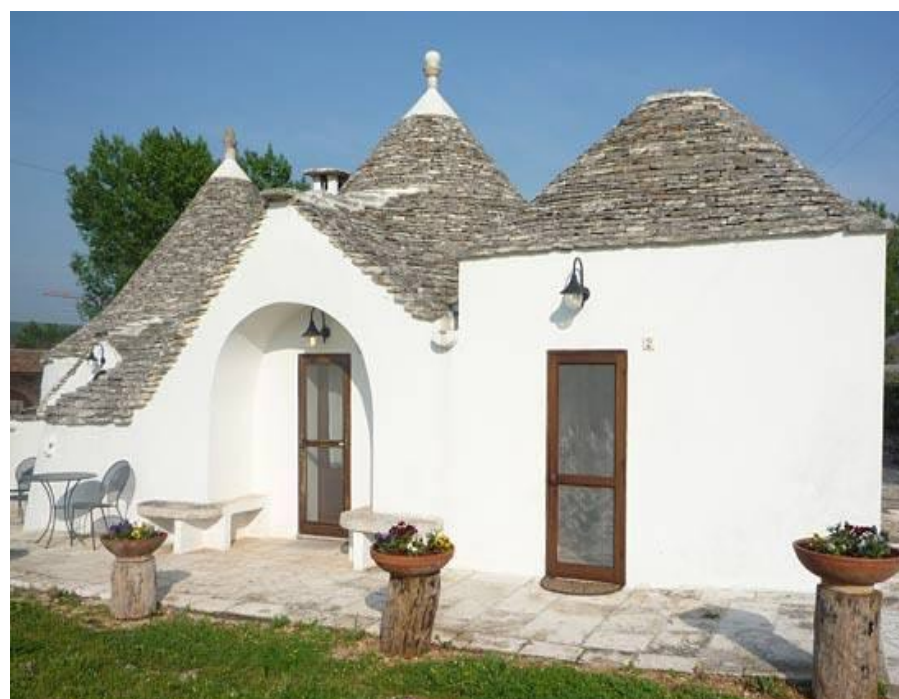
Esempi di ampliamenti di manufatti di pietra a secco con volumi a copertura piana o a volta estradossata con manto di chiancarelle
