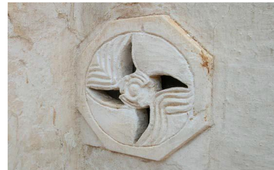
Esempio di elemento di chiusura di un foro murario di aerazione naturale
