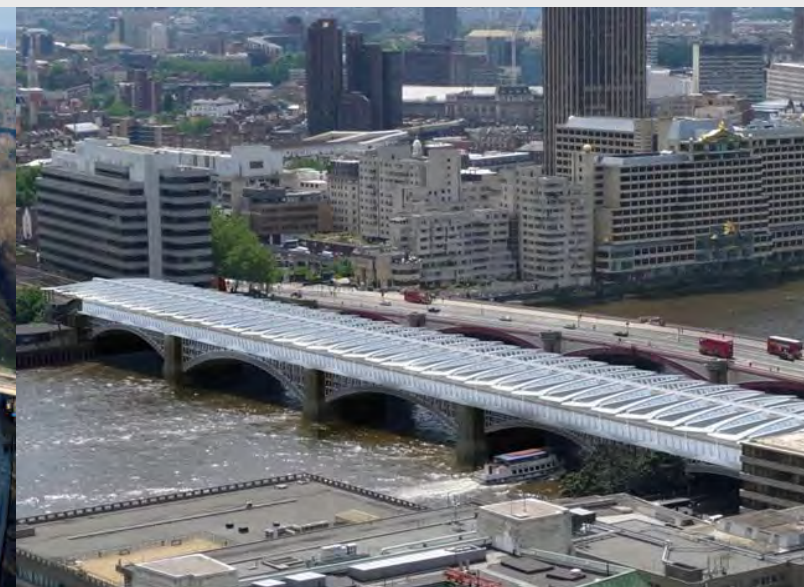
Ponte fotovoltaico. Copertura della stazione Ferroviaria di Blackfriars sul Tamigi, Londra. 4400 pannelli solari. Producibilità pari a 900 MWh.
