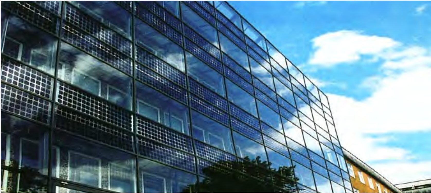
Parapetti con celle fotovoltaiche
