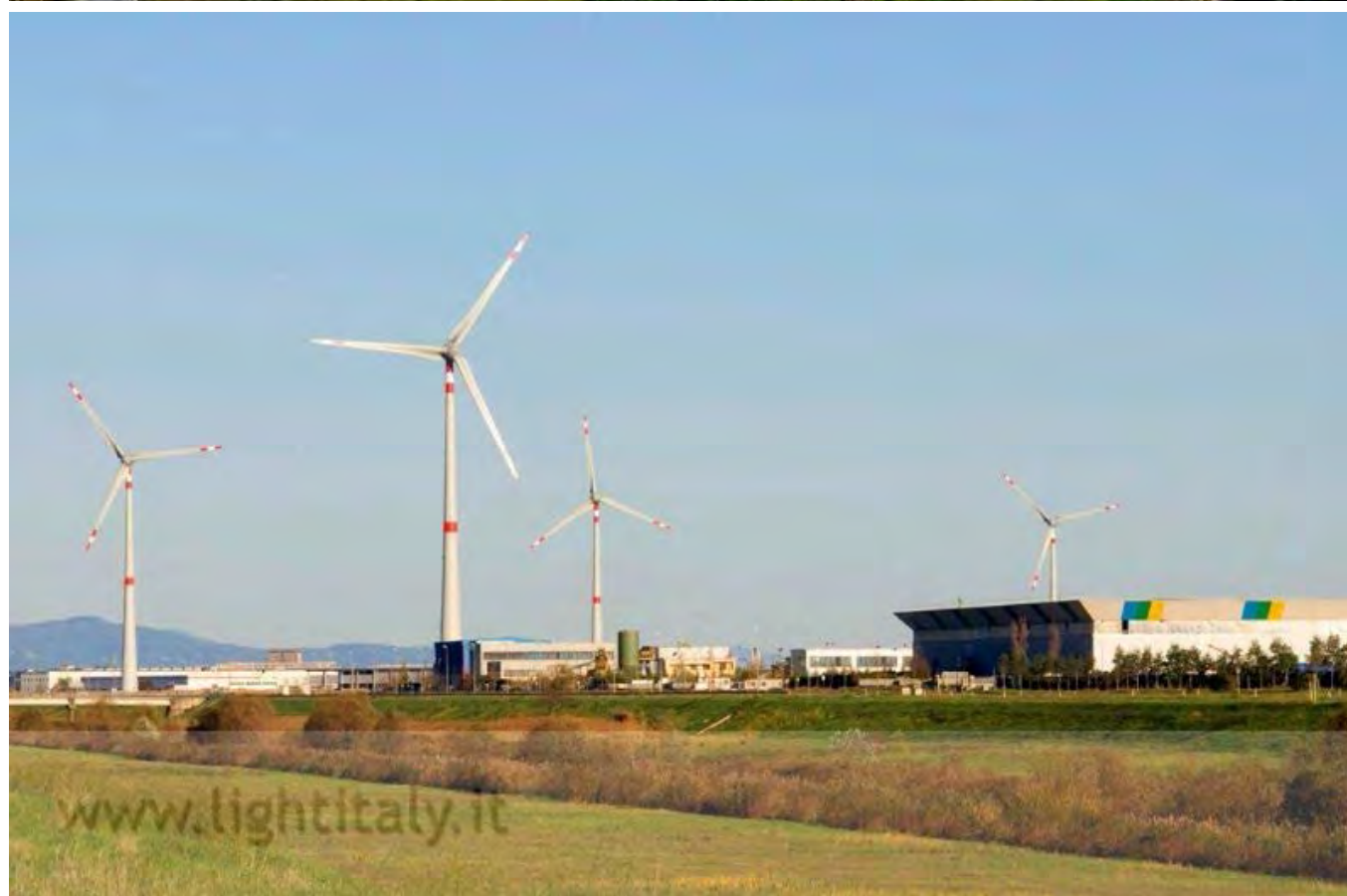
Il nuovo Parco Eolico di Pontedera (PI), sito nella zona industriale nei pressi della Piaggio lungo il canale Scolmatore, potenza di 2 MW per ciascuna torre
