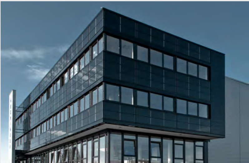
Heching , VS-Schwenningen, 164 kWp
