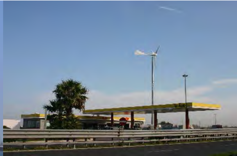
Giovinazzo. Mini eolico in una stazione di servizio AGIP
