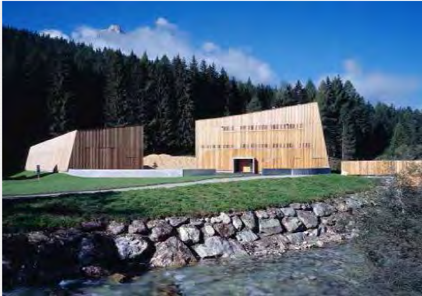
Centrale di teleriscaldamento di Sesto (BZ), 2004
