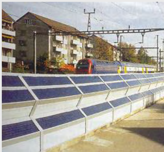
Moduli fotovoltaici utilizzati come barriere antirumore lungo arterie stradali a scorrimento veloce e lungo la ferrovia. Ferrovia di Wallisellen in Svizzera.
