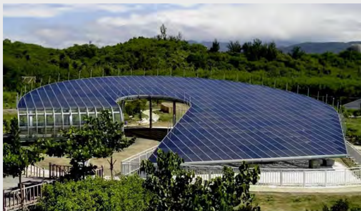
Integrazione fotovoltaico nella nuova edilizia
