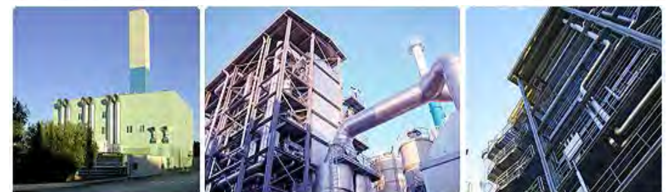
Monopoli zona industriale. Ital Green Energy srl
