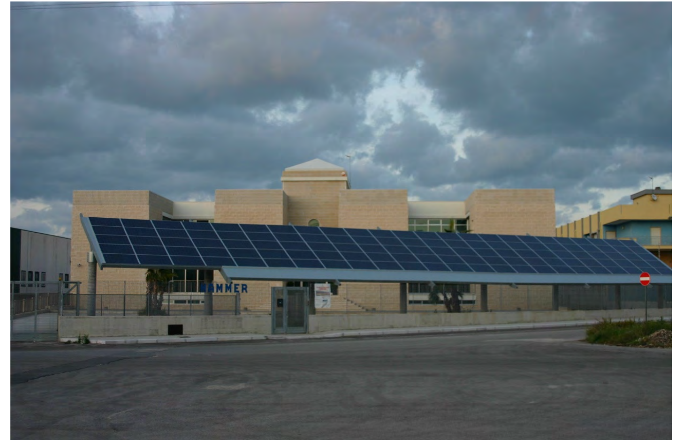
Molfetta (BA) pensilina fotovoltaica in zona produttiva
