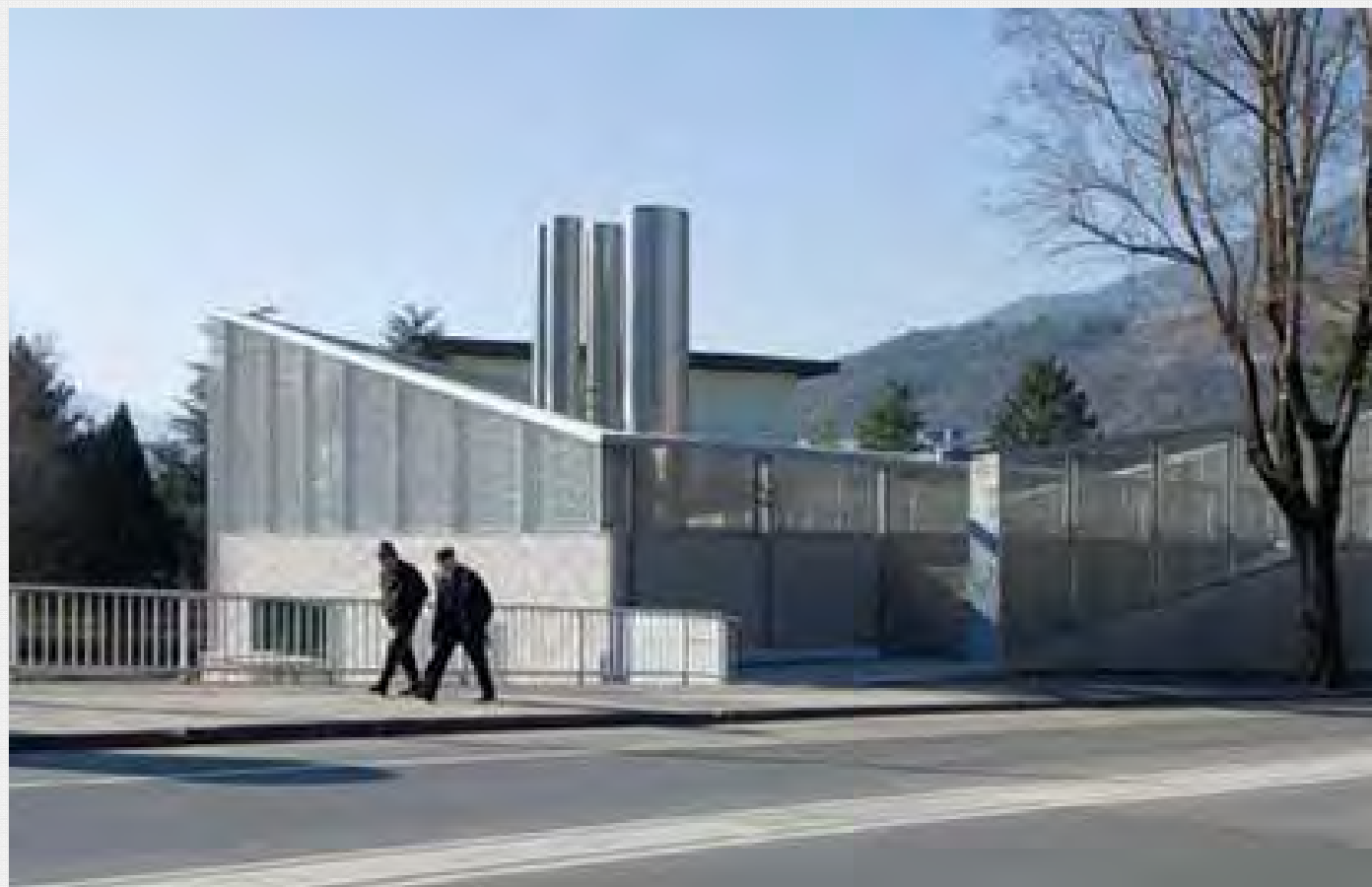
Centrale di cogenerazione di Bressanone (BZ)
