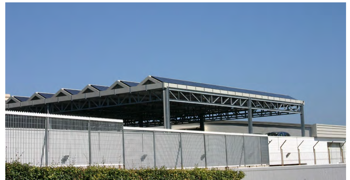
Bari zona industriale Azienda Carenza pensiline fotovoltaiche
